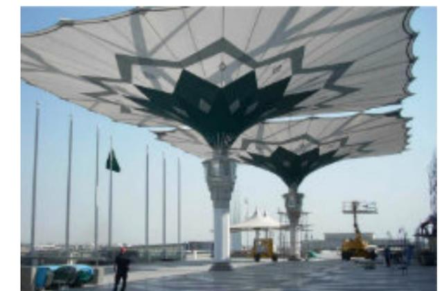
Die quadratischen Sonnenschirme, mit einer Seitenlänge von ca. 29 Meter, bieten tagsüber ausreichenden Sonnenschutz und sorgen am Abend für eine wohlthuende Lichtstimmung durch indirekte Beleuchtung der Segel – mit Bartenbach Lichttechnik
