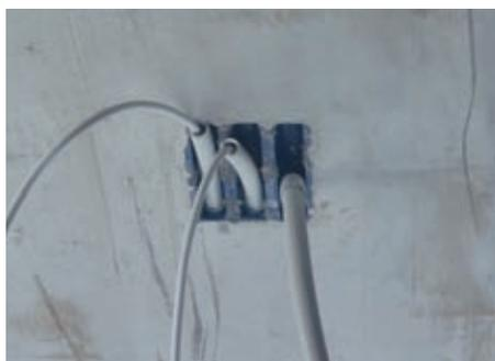
▲ Problemloser Übergang von Leitungen aus der Decke in darunter zu erstellende Leichtbauwände.
