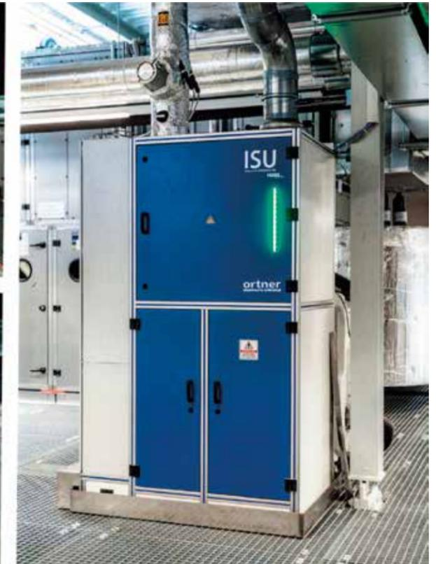
Eine vollautomatisierte Dekontaminationsanlage, die außerhalb der Reinräume positioniert wird, versorgt zentral die einzelnen Räume.
