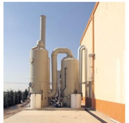
L'abbattitore ad umido "Scrubber" è un lavatore a colonna ad elementi di riempimento mobili o fissi che permettono di lavare i gas con soluzioni adatte per la loro neutralizzazione anche in presenza di particelle solide fini. Il lavaggio del gas, basato sul principio dell'assorbimento può avvenire su più strati di elementi, variabili di spessore e di numero, secondo le esigenze.
