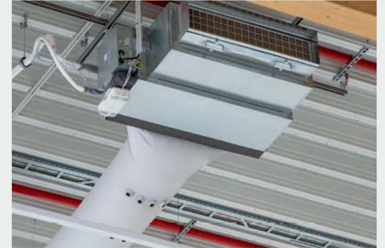
Kanalgerät mit Textilschlauch
