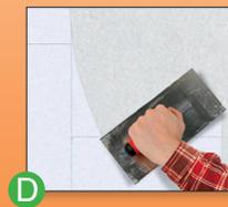
**Um die Druckfestigkeit der Platte zu erhöhen**, empfehlen wir ein festes *Maler- und Reparaturvlies* (z. B. *RV 130*) mit *Glasgewebe- und Vlieskleber GK* zu verkleben.
